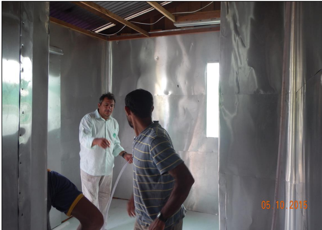
1. Preparação do revestimento interno; assoalho revestido de fibra de vidro e paredes revestidas de folhas de alumínio.
