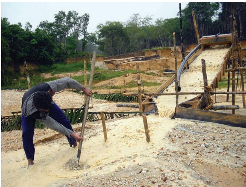
Imagem 6. Desmonte hidráulico. Por Natalia Guerrero, nov. 2011.
