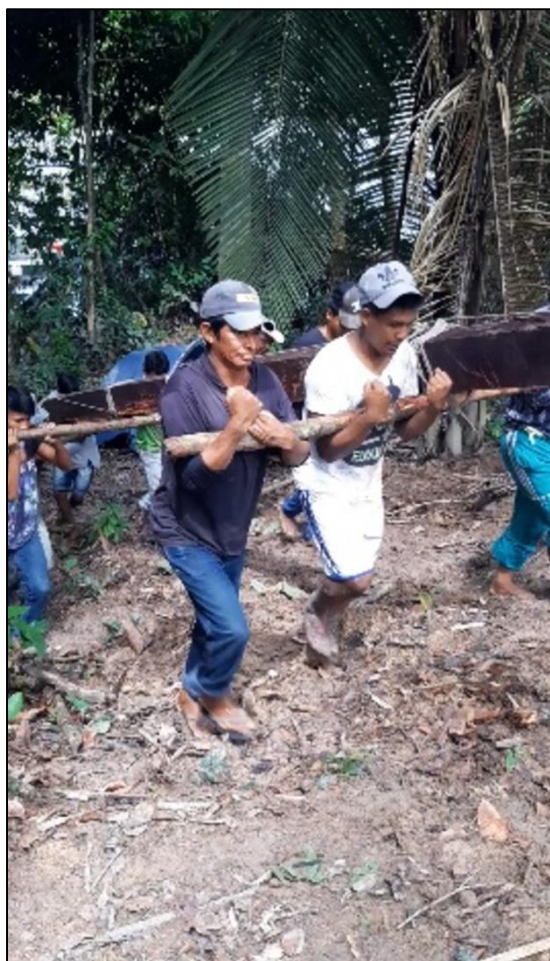
Figura 18 – Carregando os esteios novos para a estrutura da caixa d'água
